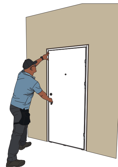
STEP 12. Kontroller lukkefunktionen og tætningen.
